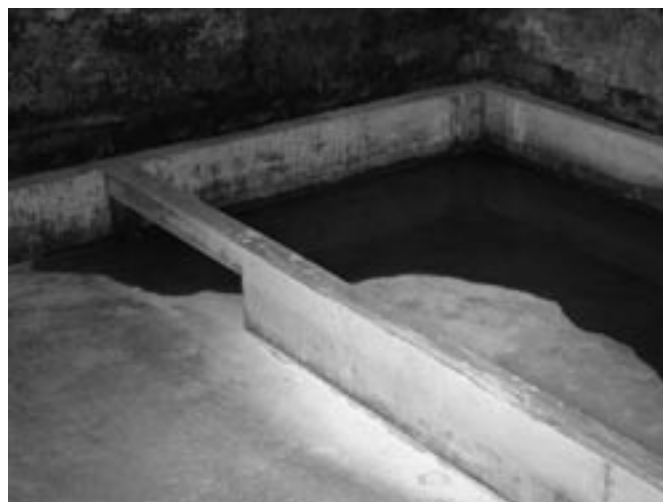
Bild 4: Betonierter Güllerkeller
