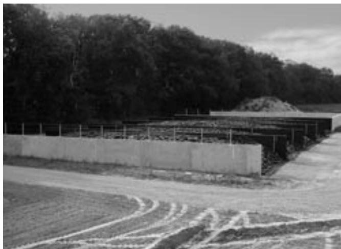
Bild 7: Rückseite der Festmist-Fahrsilo-Kombination mit tragfähiger Umfahrung
