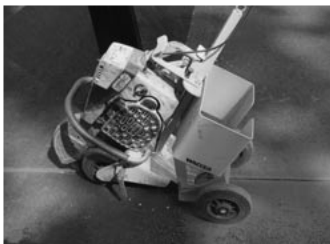
Bild 6: Schneiden der Scheinfuge
