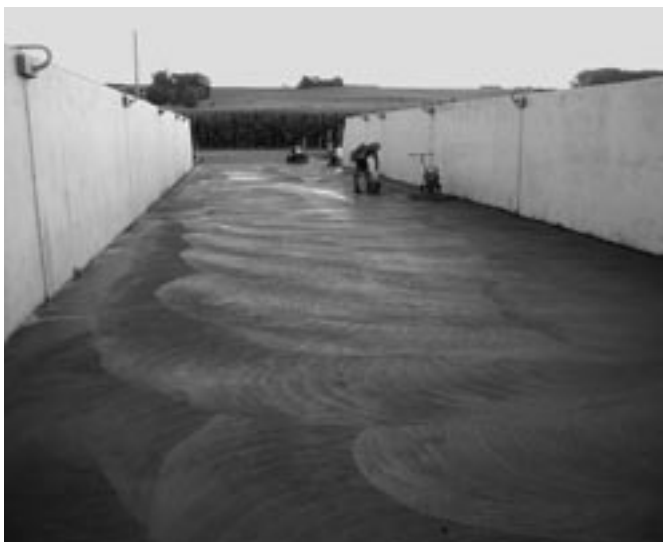
Bild 1: Herstellung der Bodenplatte eines Gärfuttersilos
