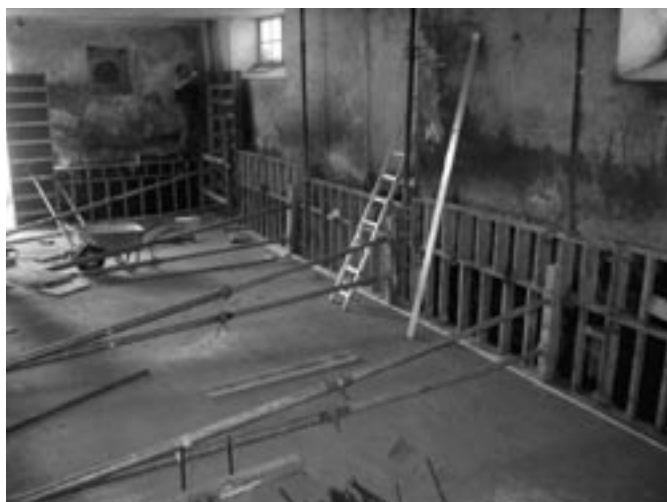
Bild 2: Schalung zum Betonieren der Spaltenbodenaufleger im Randbereich
