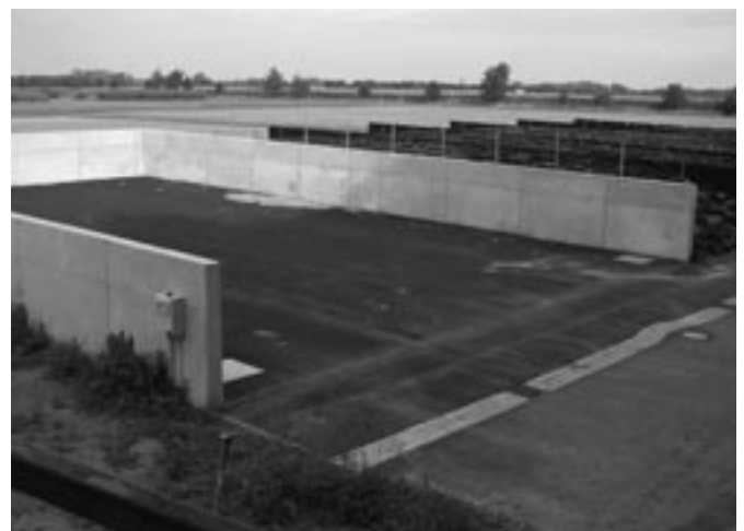
Bild 2: Fertig gestelltes Festmistlager mit dahinter liegendem Fahrsilo
