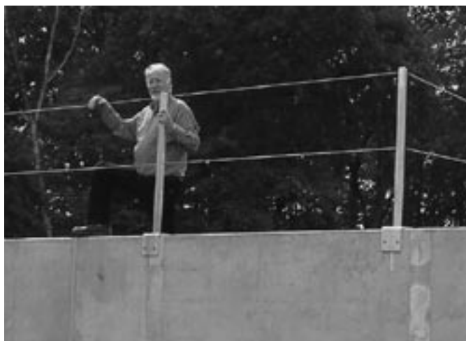
Bild 8: Absturzicherung des Fahrsilos durch Reling
