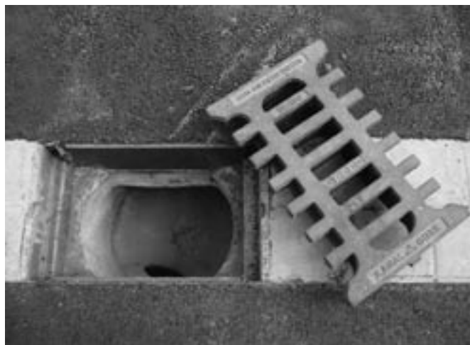
Bild 5: Entwässerungsdetail, geöffneter Einlaufschacht
