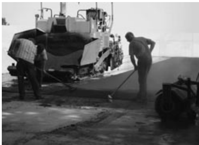
Bild 3: Einbau der Asphaltbetondeckschicht auf der Betonsole im Mistbereich
