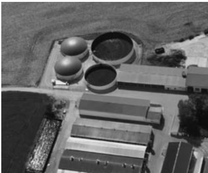
Bild 1: Behälter einer Biogasanlage (Foto HEPOLAN Heeren)
